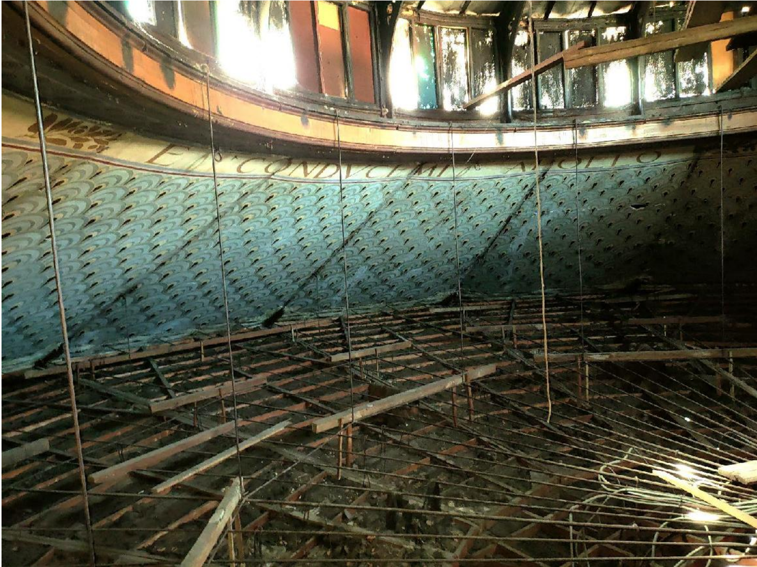
Cupola e controcupola
