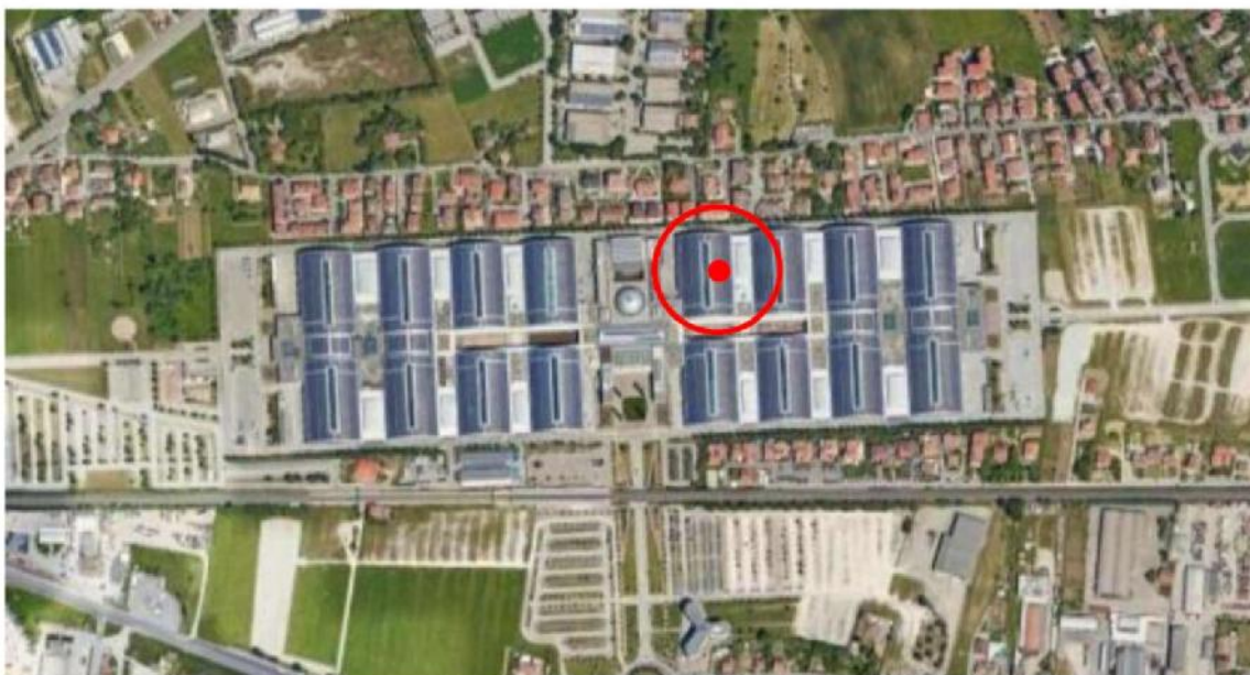
Localizzazione dell'incendio (Padiglione D1)
